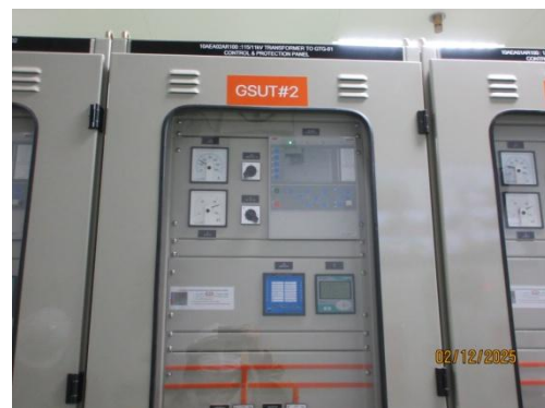
รูปที่ 3-50 ระบบป้องกันทางไฟฟ้า (Relay) บริเวณหม้อแปลงไฟฟ้า
