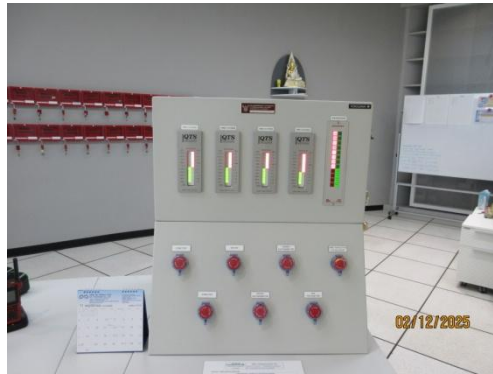
รูปที่ 3-51 ระบบสัญญาณเตือนอันตรายเพื่อหยุดการทำงานของเครื่องจักรแบบอัตโนมัติ
