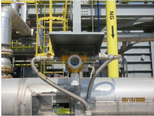
รูปที่ 3-39 Gas Detector
