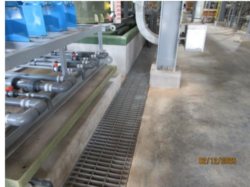
รูปที่ 3-13 รางระบายน้ำเสียของโครงการ
