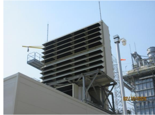
รูปที่ 3-40 ระบบระบายความร้อน ในห้องกังหันก๊าซ
